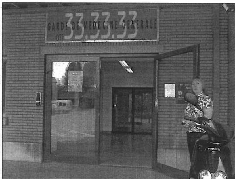
Quatre cabinets médicaux, une salle d'attente, des sanitaires attendent les patients qui franchiront, à partir du 27 avril, les portes du poste de garde de médecine générale.
